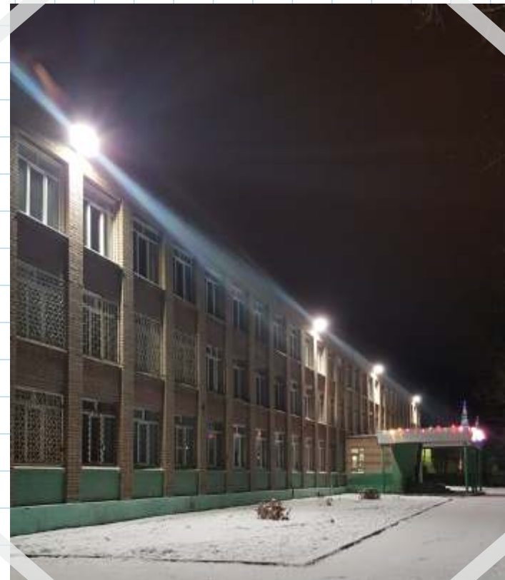
Наружное освещение. Школа №30, г. Ярославль
